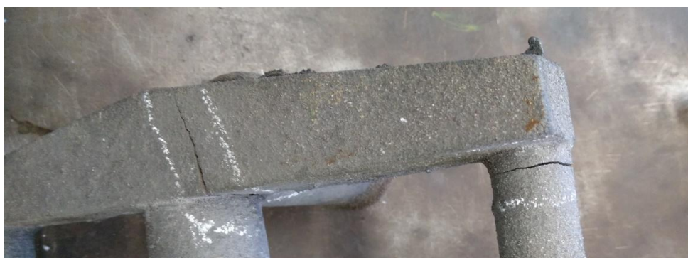
Obr. 3. Trhlina pod nálitkem střední tyče s nalomením krajní tyče
